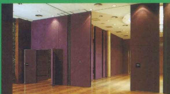
Detalle de puerta doble en módulos de perfilera oculta con acabado tapizado.
